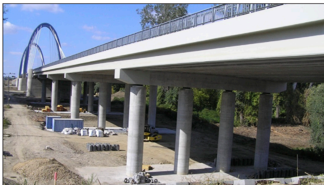
4. ábra: M44 Tiszakürti Tisza híd ártéri szakasza
